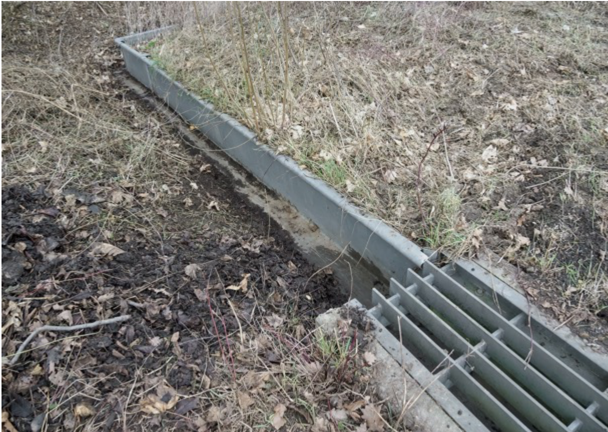
Das Fallgitter und der festinstallierte Leitschutzzaun nach der Reinigung. 27.02. 2021
